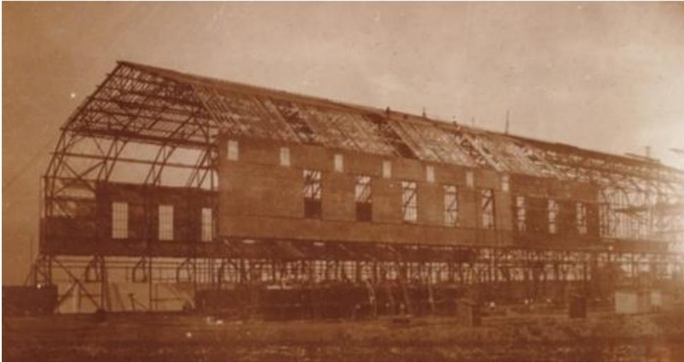
Luftschiffhalle im Bau. Die filigrane Stahlkonstruktion wurde mit Tektonplatten verkleidet. Bild Archiv Zeppelin Museum.
