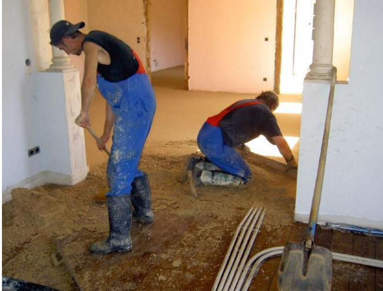
Verlegen eines Steinholzestrichs im Verbund auf einer Holzbalkendecke mit Dielenbelag. Es entsteht der Eindruck eines massiven Bodens ohne Knarr- und Resonanzgeräusche. Bild Chini Fußbodenbau GmbH & Co. KG.
