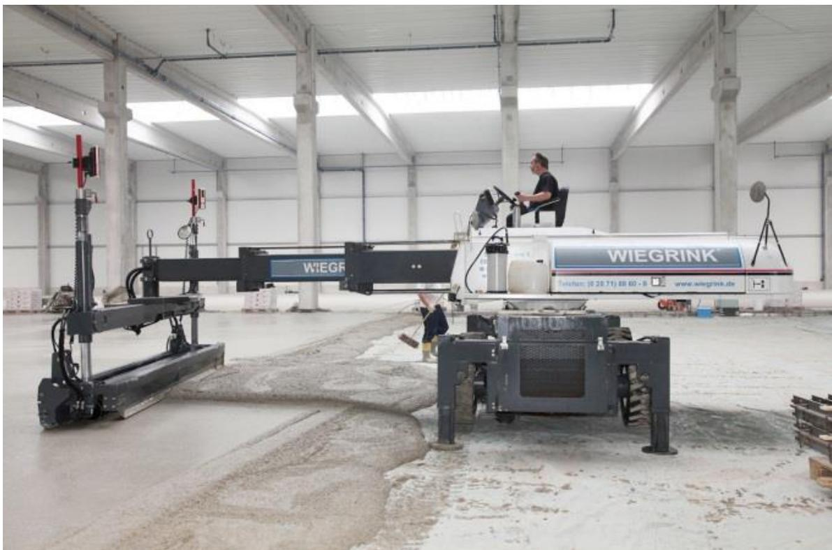
Einbau eines monolithischen Betonbodens mit Laser-Screed. Bild.: Wiegrink.
