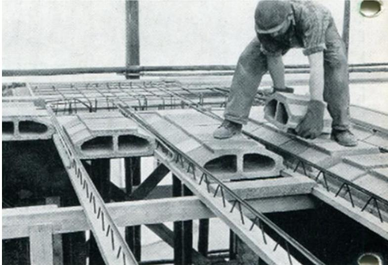
„Omnia“ Decke. Einlegen der Betonholsteine. Der Trägerbereich wurde danach ausbetoniert. Bild aus einem Prospekt der Filigranbau Kessler KG 1965
