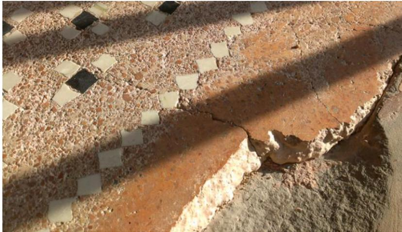
Römischer Zementestrich aus drei Teilen zerstoßenen Ziegeln und einem Teil gebranntem und gelöschtem Kalk. Die Originaloberfläche ist am Rand noch zu erkennen. Sie wurde zwar angeschliffen, die Körner wurden jedoch nicht terrazzoartig freigelegt. Pompejanum, Aschaffenburg. Bild Böhl
