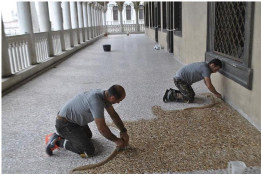
Wartungsarbeiten am Terrazzo des Laubengangs im Dogenpalast in Venedig. Der Boden wurde leicht angeschliffen und wird hier mit Leinöl eingelassen. Auch nach mehreren hundert Jahren ist der Terrazzoboden nach einer solchen Wartung wie neu. Bild Vianello Pavimenti.
